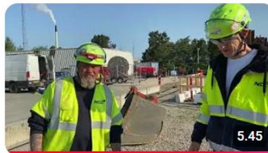
Afstivning af jernplader ved udgravninger
